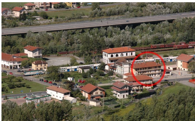
Nel cerchio rosso l'ex Ristorante Avidano davanti alla stazione
